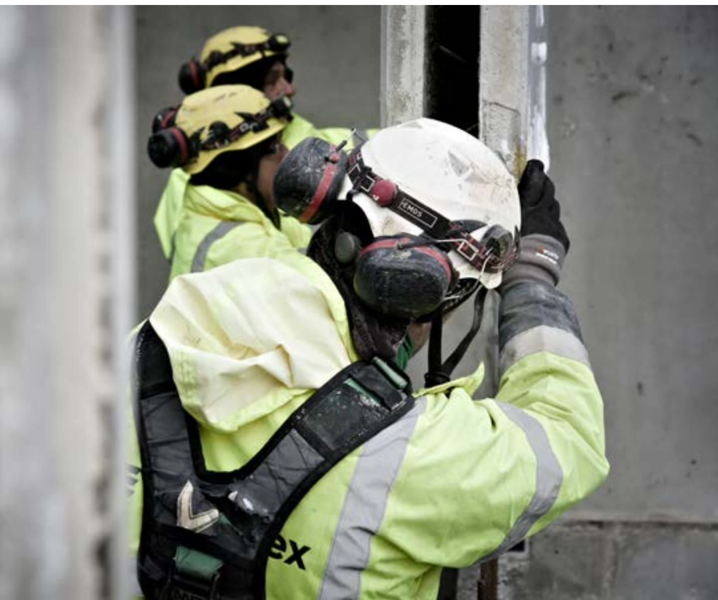
Montaż konstrukcji prefabrykowanej, Gdynia
