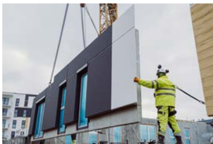
Montaż ścian na Osiedlu JA_SIELSKA, Poznań
