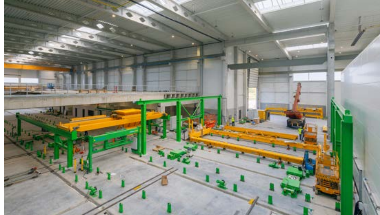
Budowa nowoczesnego zakładu Pekabex w Gdańsku-Kokoszkach
