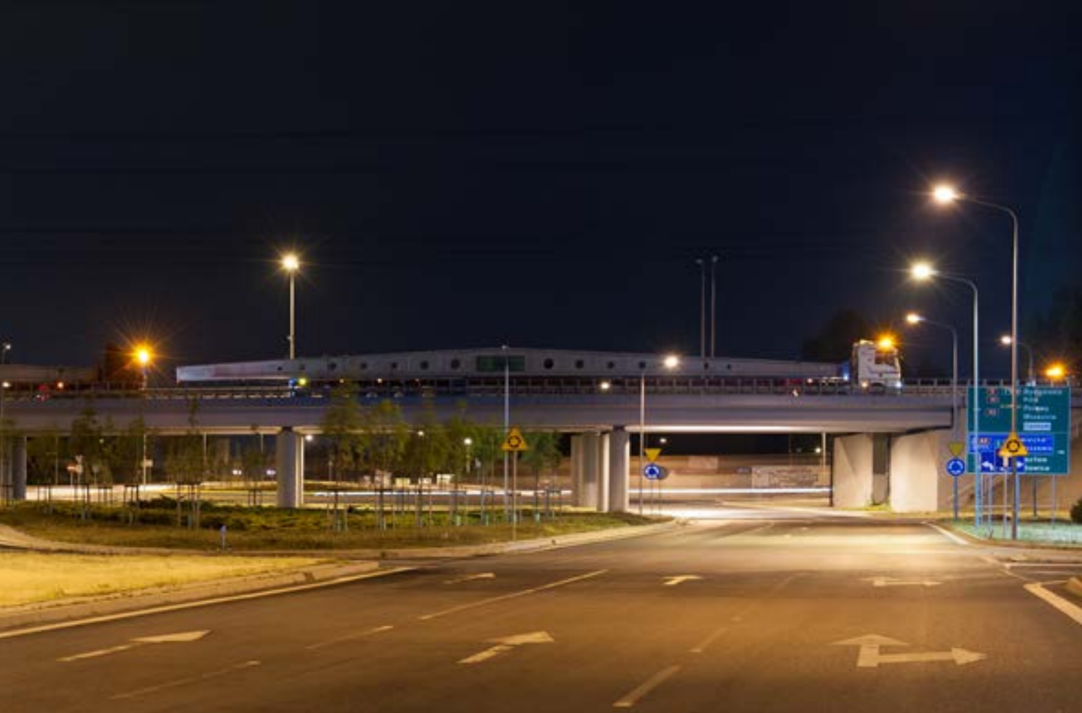
Transport elementu ponadgabarytowego (dźwigar)
