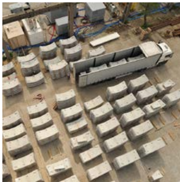
Elementy do budowy tunelu w Łodzi
