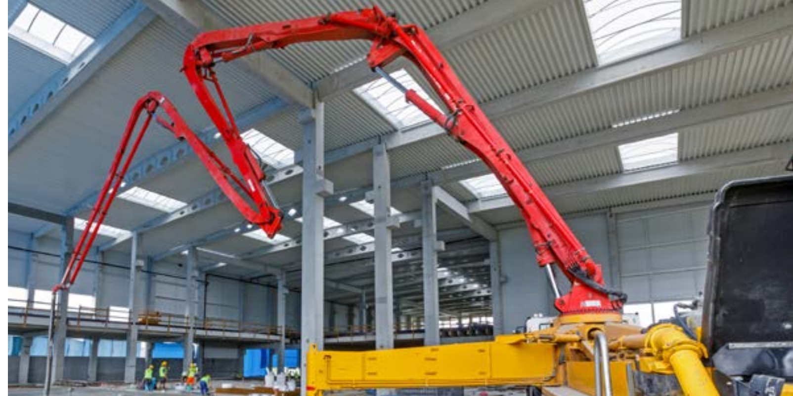
Budowa nowoczesnego zakładu Pekabex w Gdańsku-Kokoszkach
