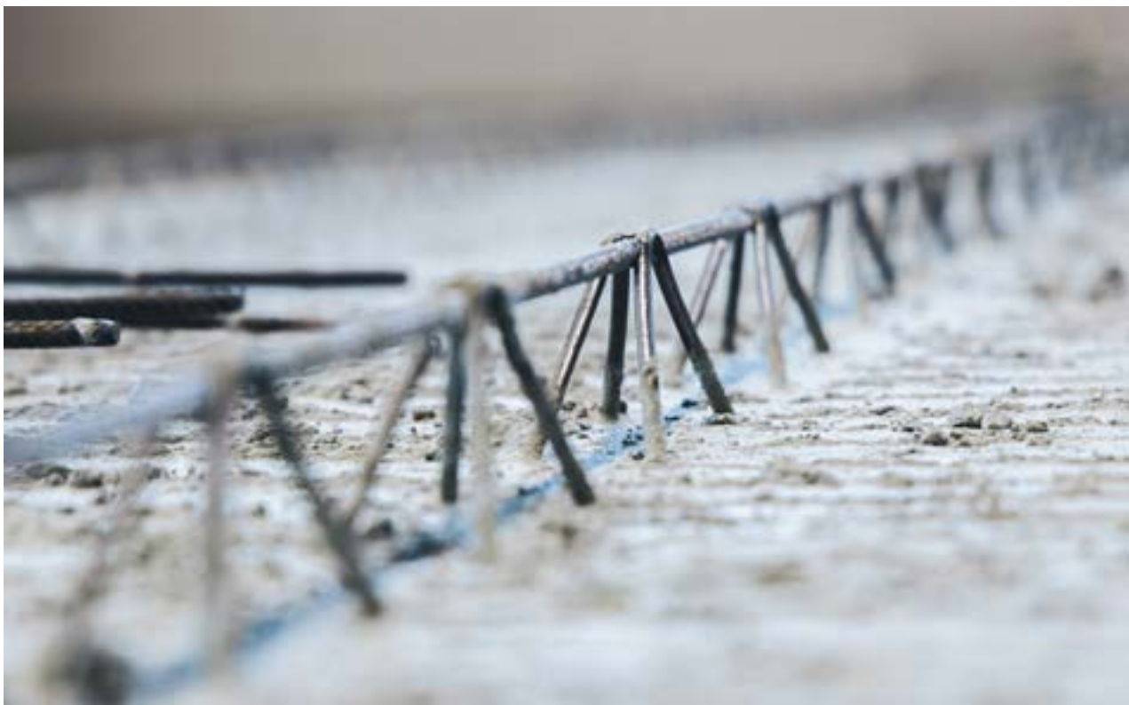
Element prefabrykowany typu Filigran
