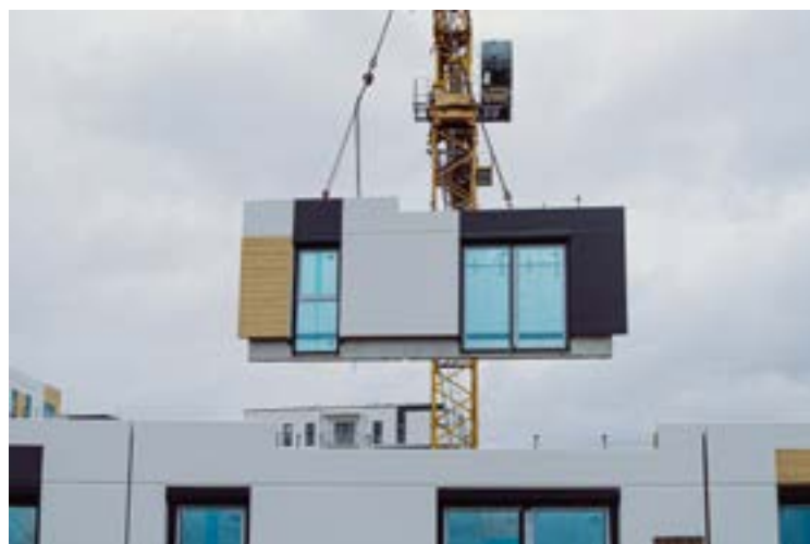
Montaż ścian na Osiedlu JA_SIELSKA, Poznań
