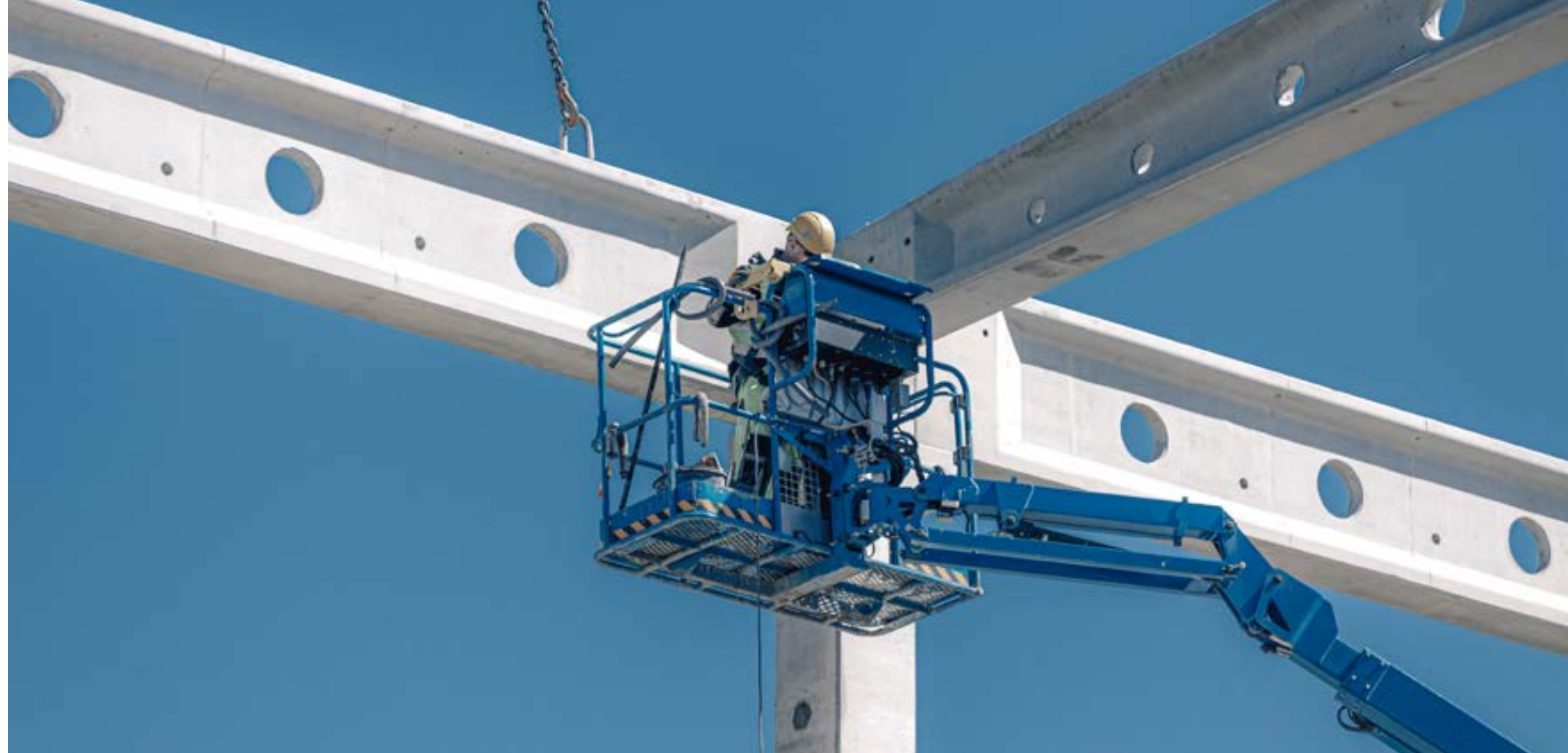
Montaż konstrukcji hali Panattoni, Bielsko-Biała
