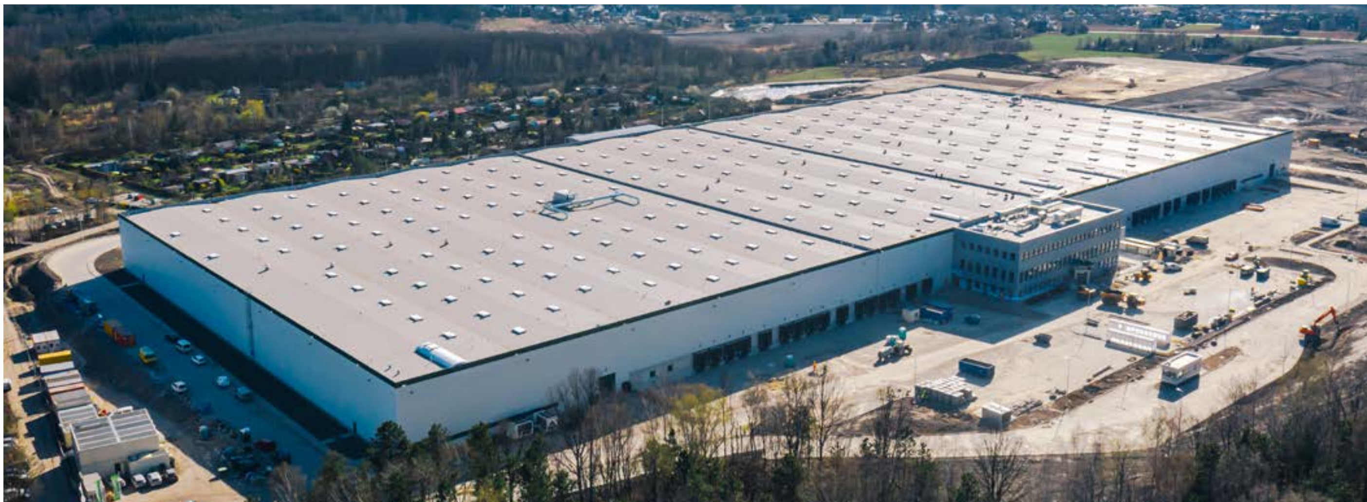
Hala Prologis, Ruda Śląska
