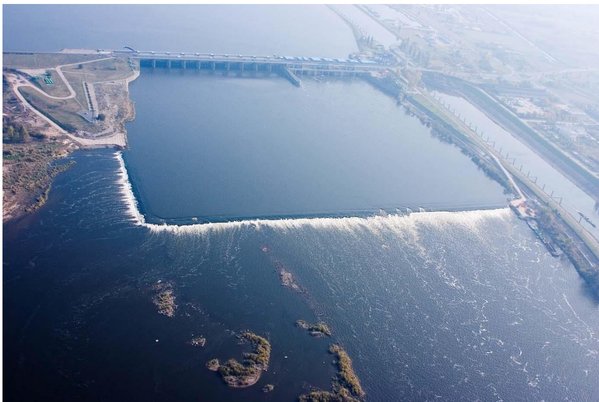
Elektrownia wodna we Włocławku
