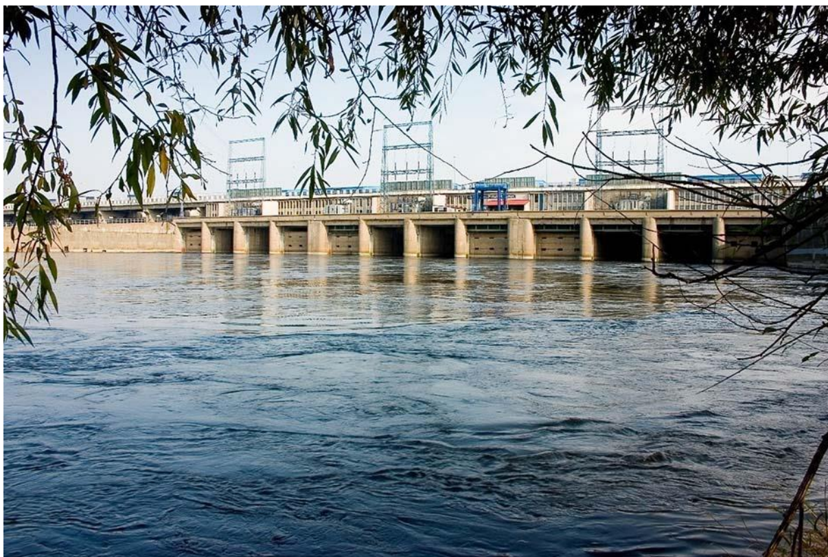
Elektrownia Wodna we Włocławku
