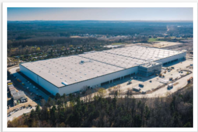
Hala Prologis, Ruda Śląska
