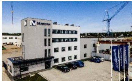
Siedziba Mostostal Kielce S.A.
