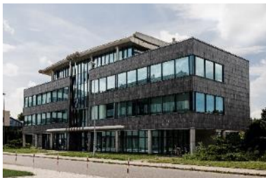
Siedziba AMK Kraków S.A.
