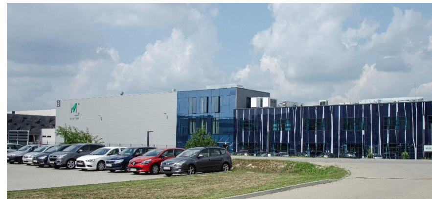
Fot. 44 Budynek B ML System – nowa hala produkcyjna
