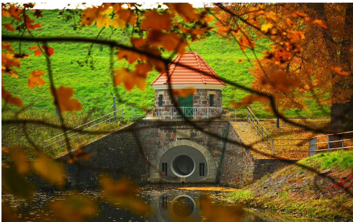
Elektrownia Wodna w Straszynie
