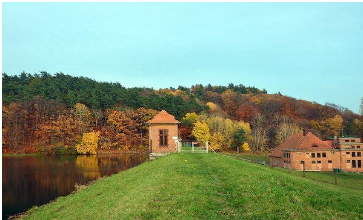
Elektrownia Wodna w Łapinie
