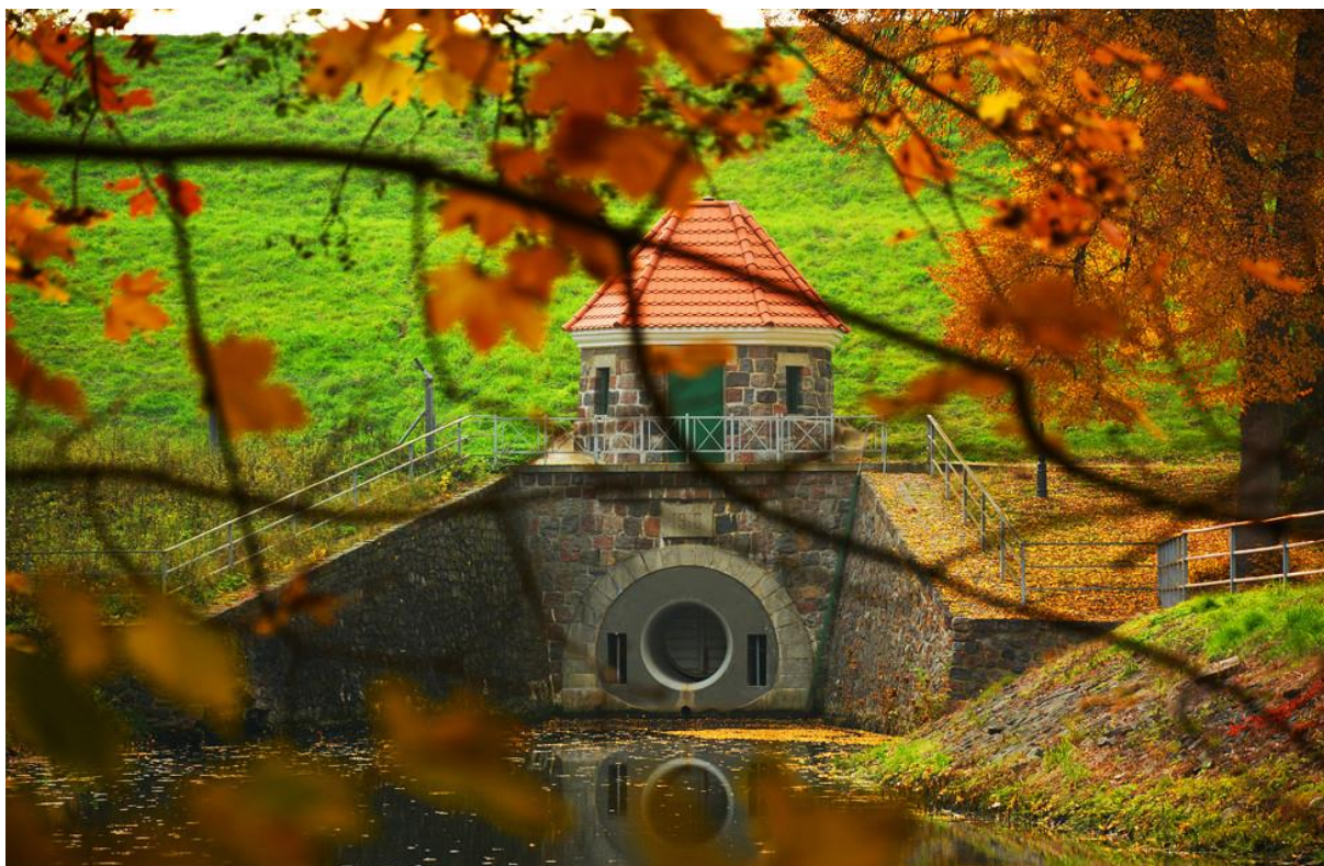
Elektrownia Wodna w Straszynie
