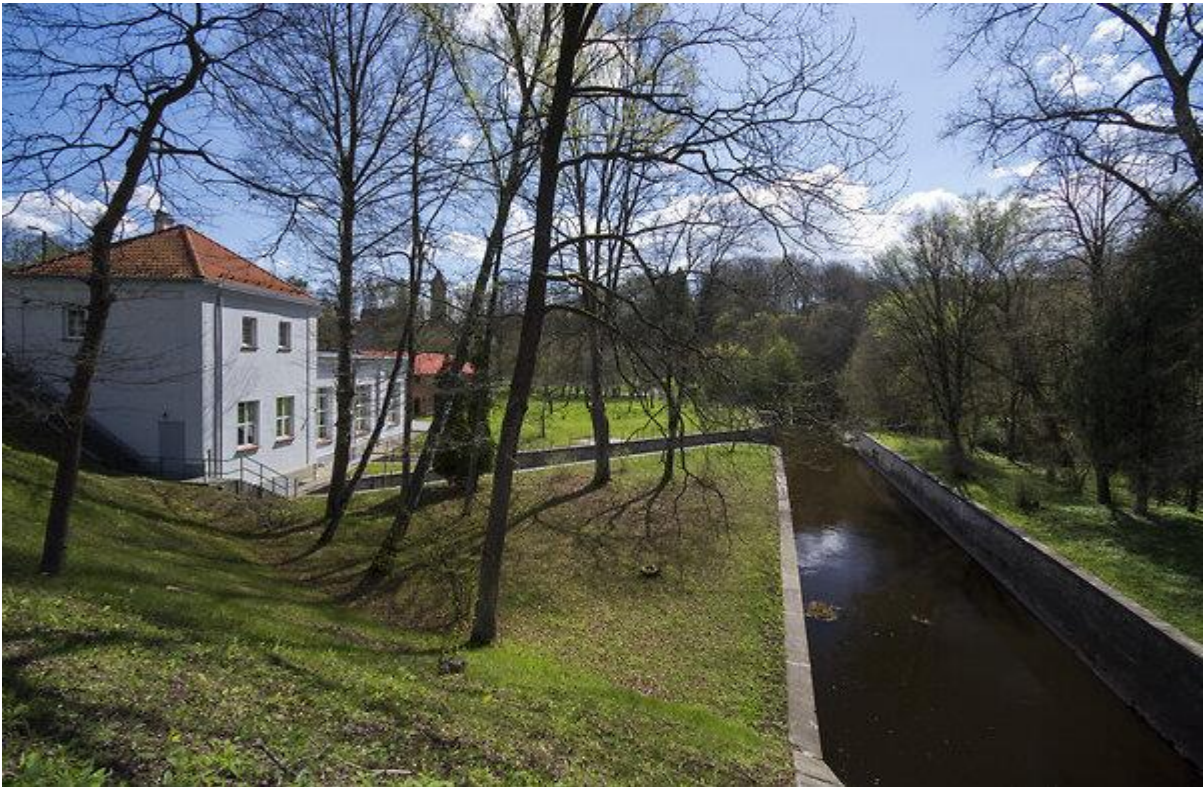
Elektrownia wodna Pieniężno
