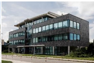
Siedziba AMK Kraków S.A.
