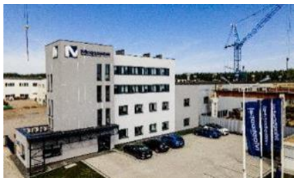
Siedziba Mostostal Kielce S.A.
