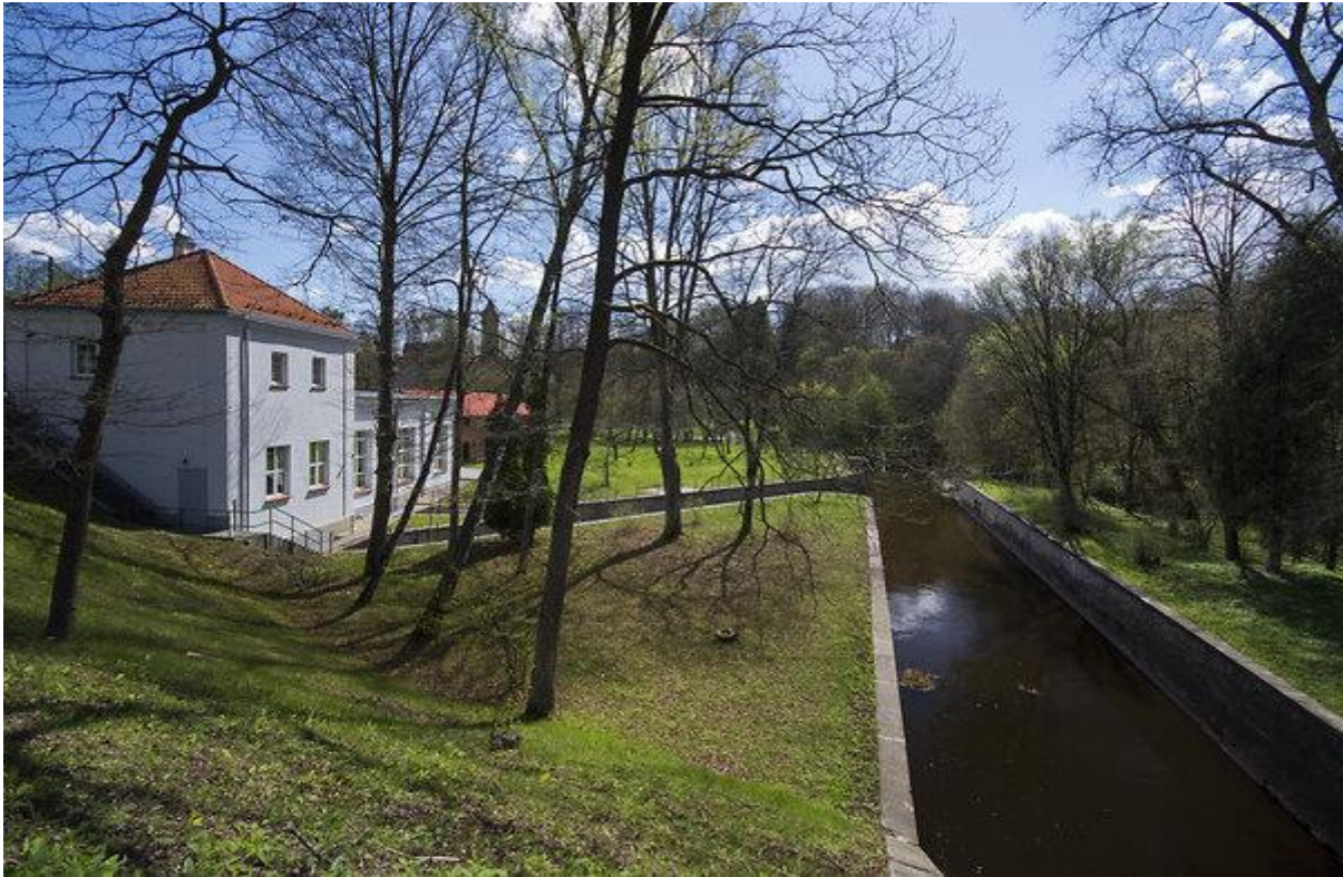
Elektrownia wodna Pieniężno
