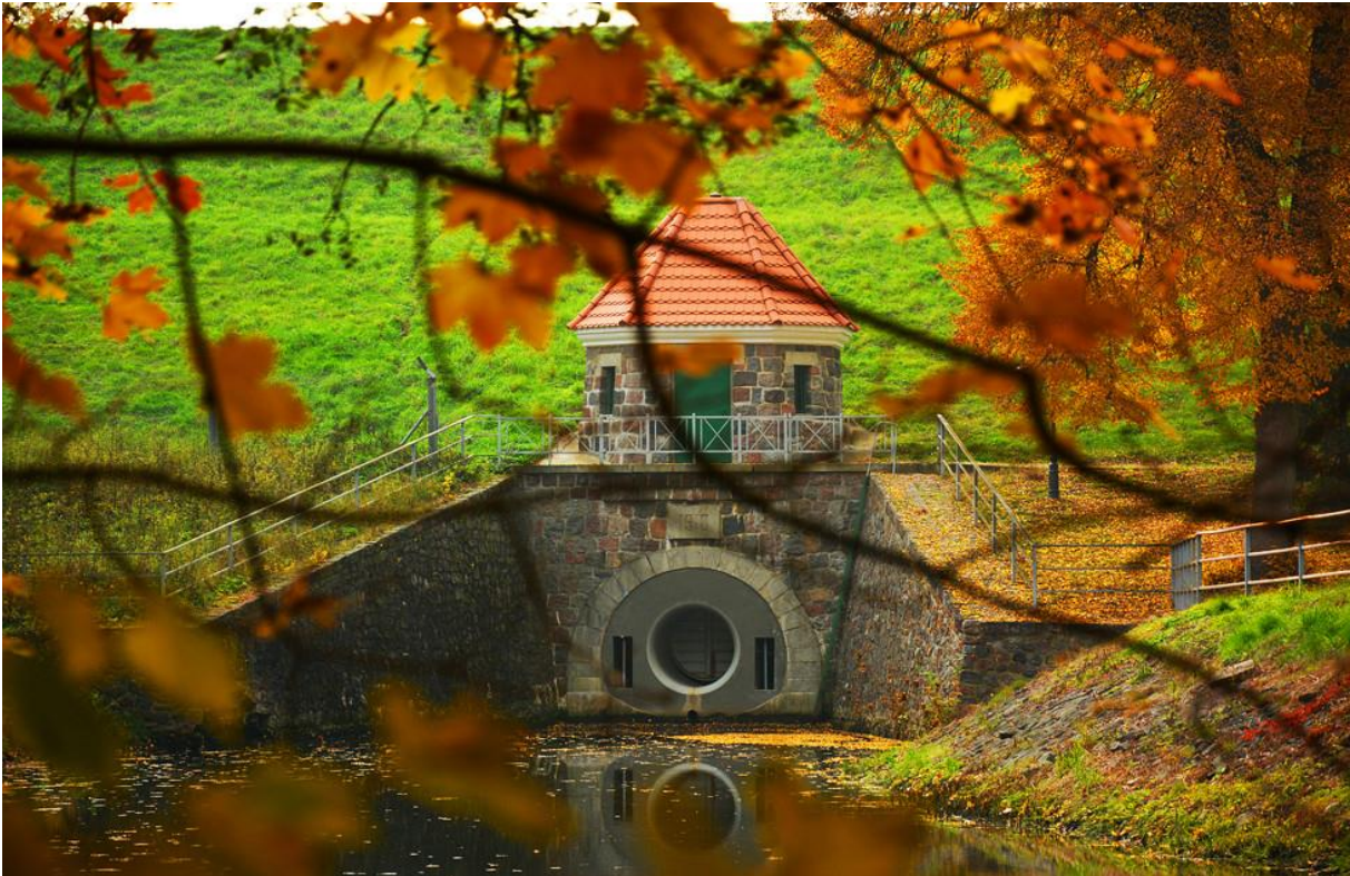
Elektrownia Wodna w Straszynie
