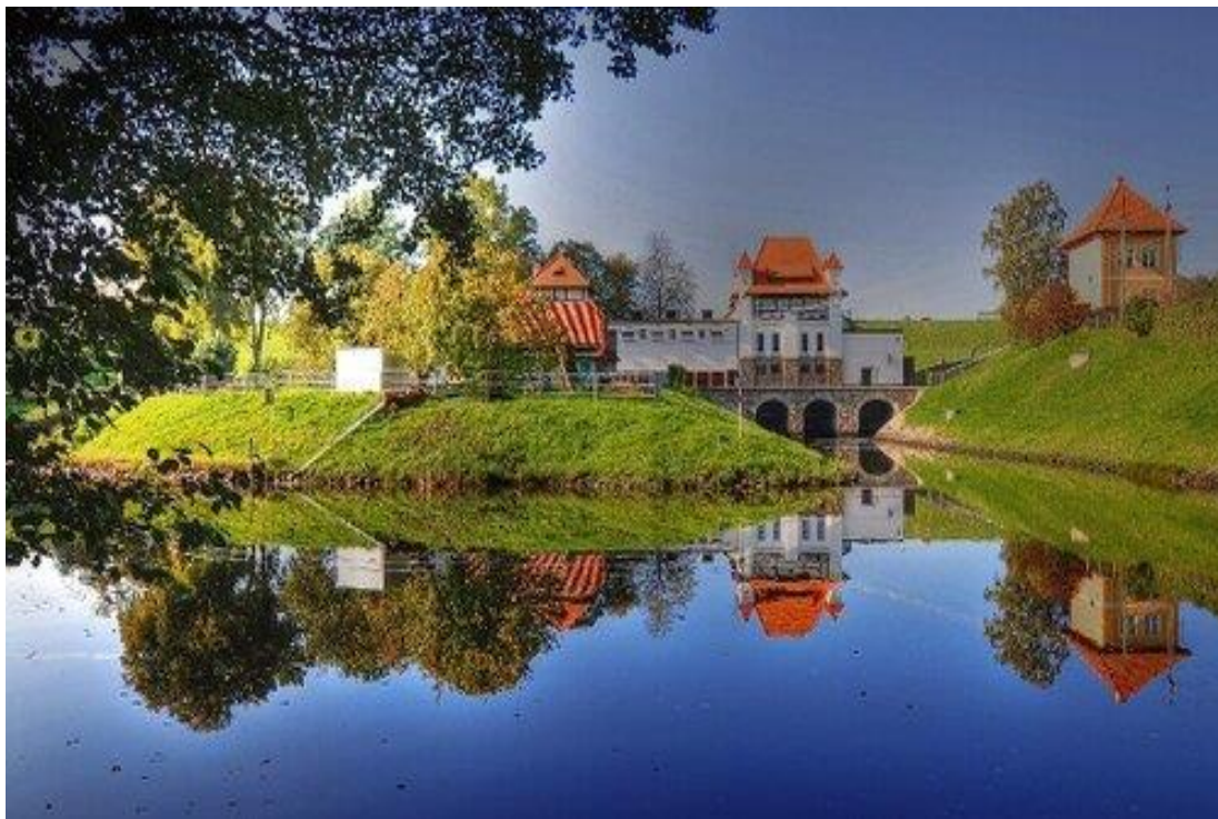
Elektrownia Wodna w Straszynie
