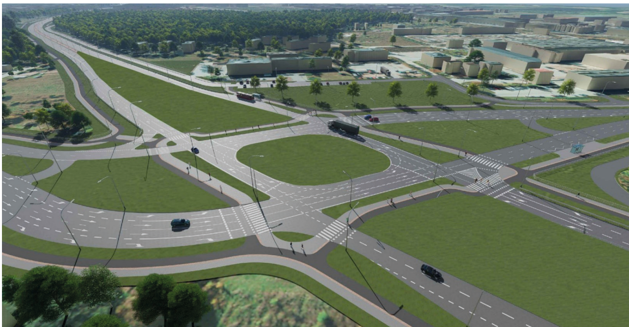
Budowa węzła drogowego w Porostach: ul. Gen. F. Kleeberga - droga krajowa Nr 8 - droga wojewódzka Nr 676 - ul. Aleja Jana Pawła II w ramach projektu: Poprawa dostępności komunikacyjnej miasta Białegostoku od strony Warszawy - włączenie do trasy ekspresowej S8 (źródło: www.bialystok.pl)
