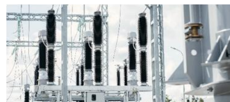
Polskie Sieci Energetyczne. Rozbudowa rozdzielni 220 kV i 110 kV w stacji 220/110 kV Adamów. Wartość 34 mln PLN
