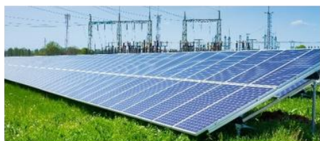
Polskie Sieci Elektroenergetyczne. Rozbudowa i modernizacja rozdzielni 220 kV w stacji 400/220/110 kV Pątnów. Wartość 18 mln PLN
