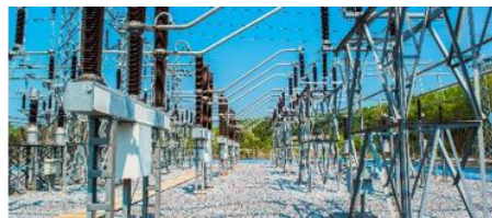
Tauron Dystrybucja. Budowa GPZ Chrzanów Strefa. Wartość 42 mln PLN
