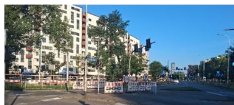
Gmina Wrocław. Remont torowiska Bardzka we Wrocławiu. Wartość 10 mln PLN
