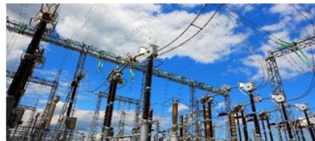
Enea Operator. Przebudowa stacji 110/15 kV Golczewo na terenie OD Szczecin. Wartość 23 mln PLN
