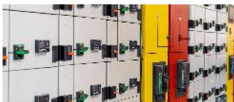
Tauron Dystrybucja. Budowa rozdzielni 20 kV w stacji elektroenergetycznej Wirek. Wartość 21 mln PLN
