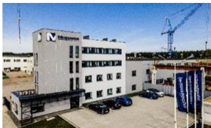
Siedziba Mostostal Kielce S.A.
