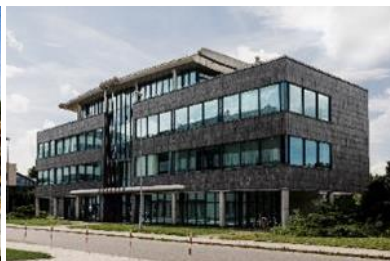
Siedziba AMK Kraków S.A.
